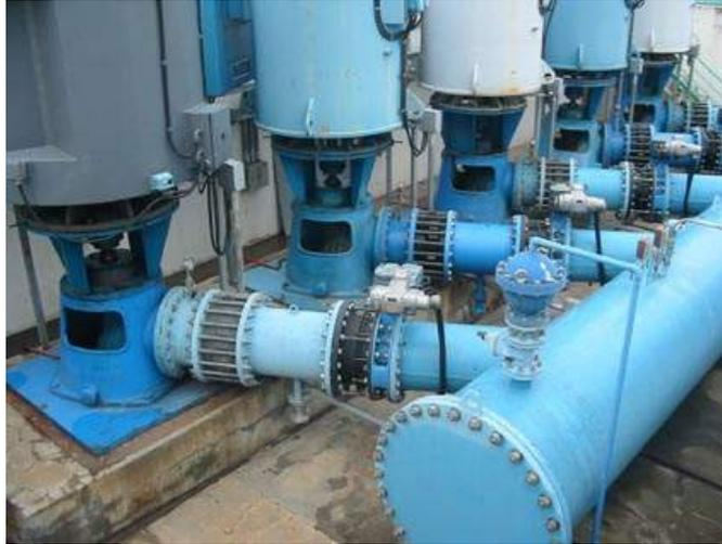
Fig. IV 12.- Colector de descarga con acometidas a 45°.
