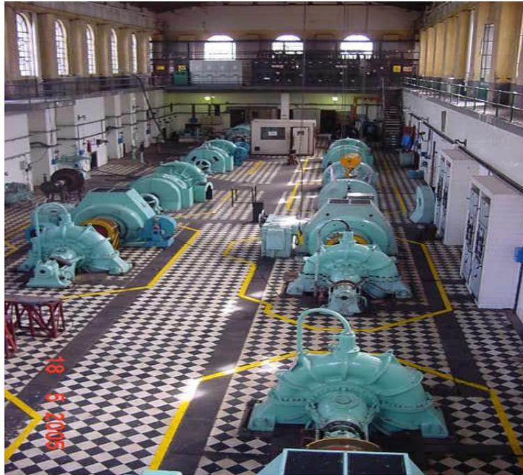
Fig. I.5.- Estación de bombeo de cámara seca
