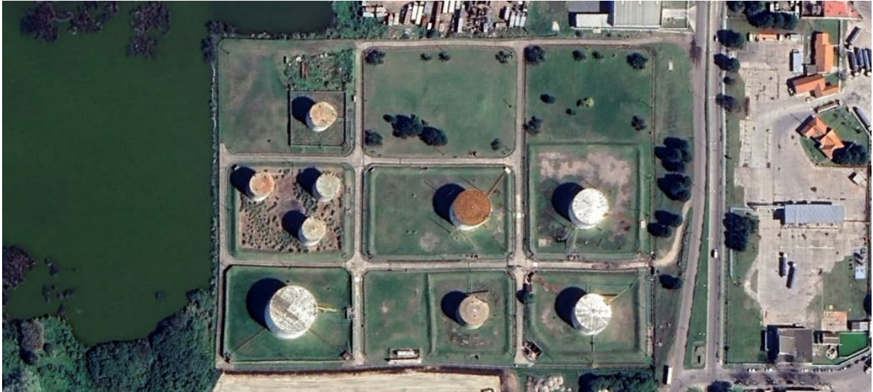
Figura 17: Parque de tanques de combustibles
