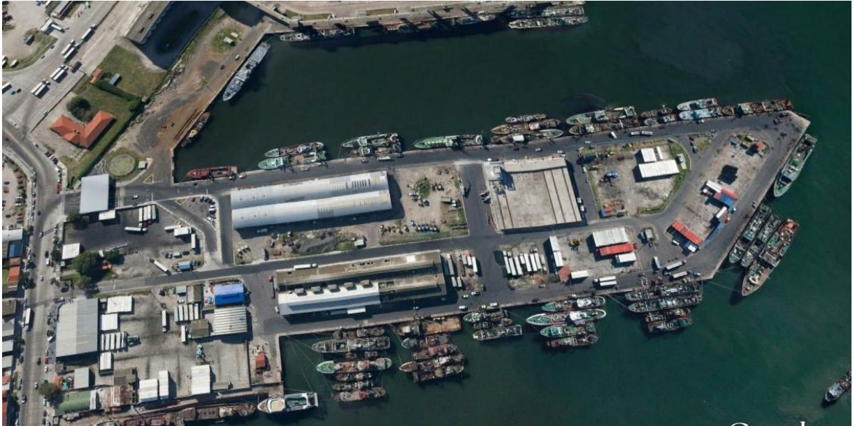
Figura 9: Espigón 2 del Puerto de Mar del Plata
