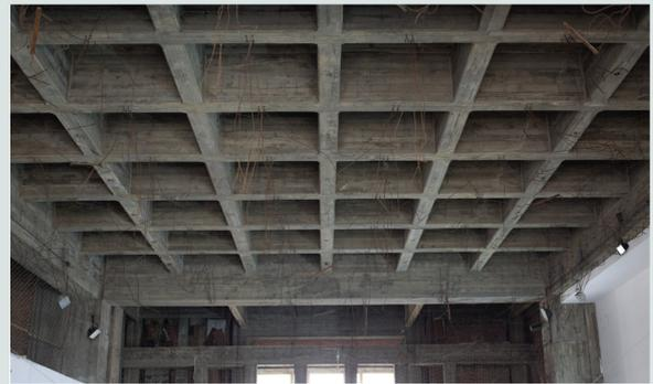
Vista Techo existente (casetonado de hormigón) - Actual
