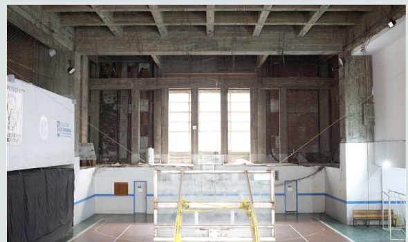
Lado vestuarios desde altura - Actual
