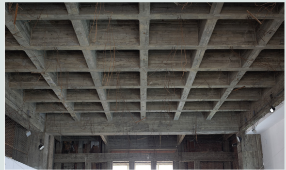
Vista Techo existente (casetonado de hormigón) - Actual
