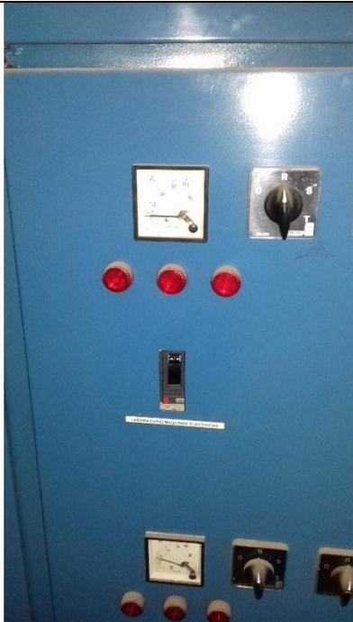
Panel frontal cubicle interruptor salida a laboratorio máquinas eléctricas
