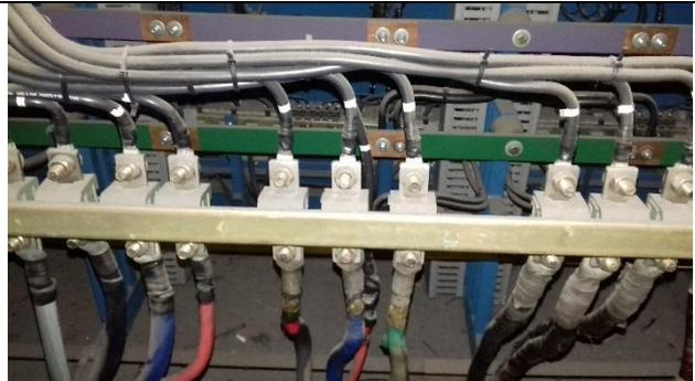
Borneras de conexión a cables de salida, ubicadas en parte posterior de tablero. Terna ubicada a la izquierda: línea de alimentación a tablero seccional D.
